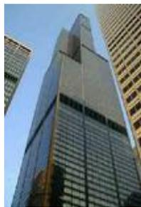
图1 束筒结构实例
