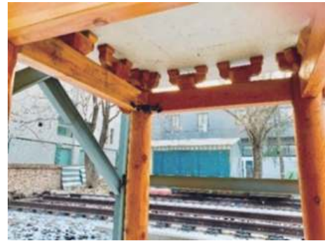
图 18 中国古建筑木结构裂缝监测系统工作过程
